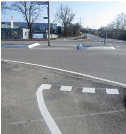
Ausbau des Radweges entlang der L1113.
